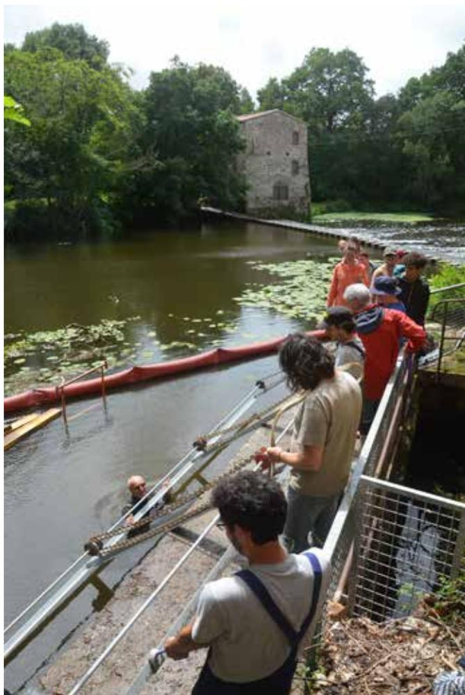
Installation d'un dégrilleur automatique<sup>5</sup>
